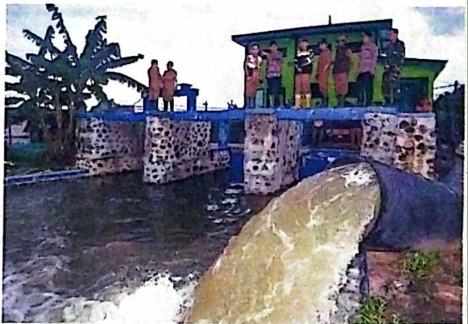
CEK LANGSUNG: Bupati Sidoarjo Ahmad Muhdlor Ali (empat dari kiri) meninjau Rumah Pompa Kedungbanteng, Kecamatan Tanggulangin, kemarin.
