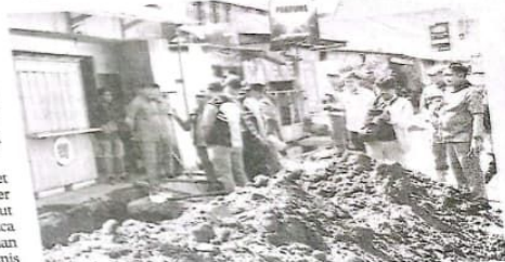
Bupati Sidoarjo sidak proyek Jalan Bluru Kidul.
