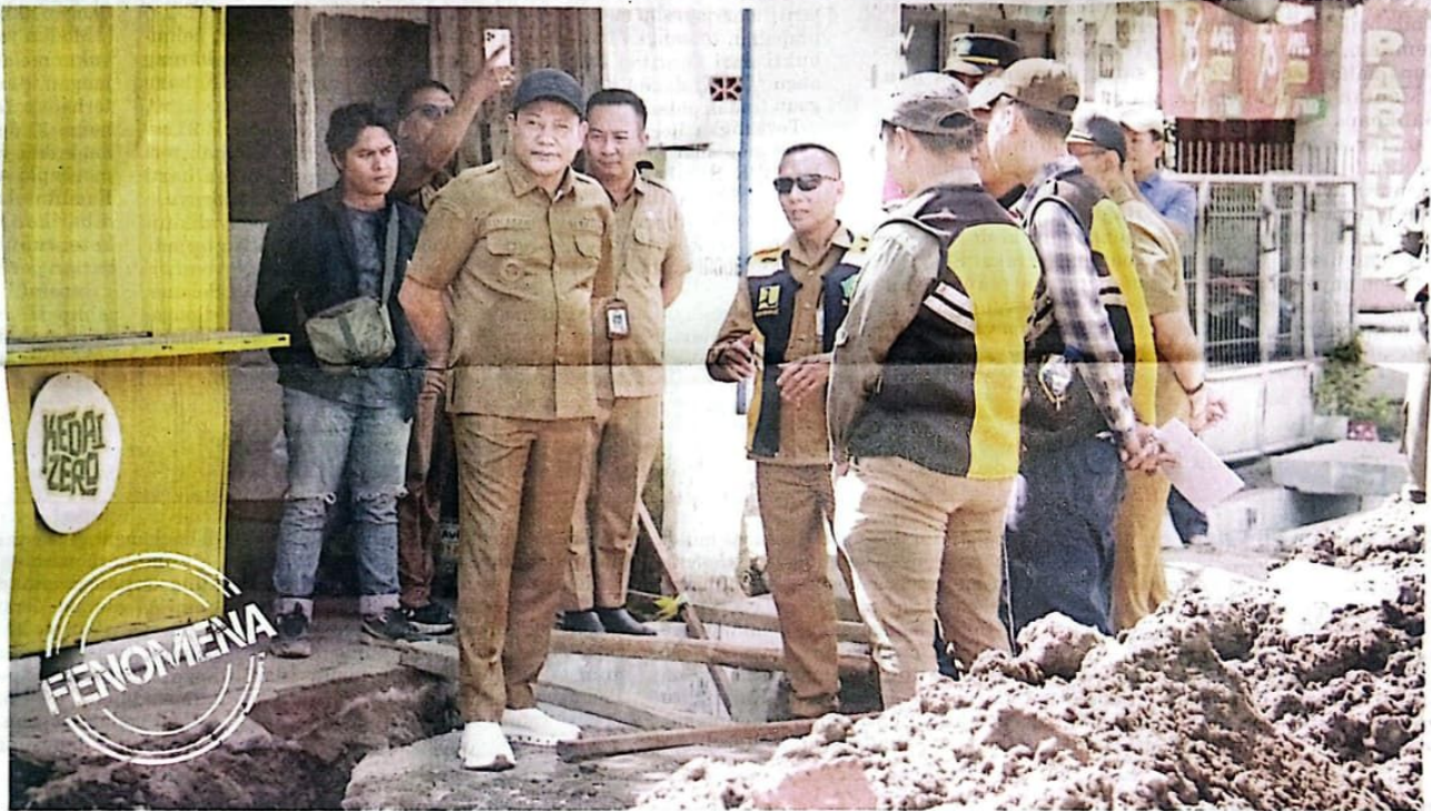
INFRASTRUKTUR: Bupati Sidoarjo Subandi meninjau proyek betonisasi Jalan Raya Bluru Kidul yang ditargetkan mampu mengatasi banjir sekaligus memperlancar akses menuju pusat pelayanan publik.
