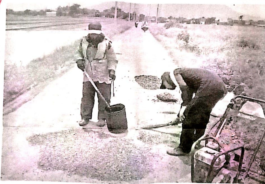
DITAMBAH: Tim Satgas Jalan Dinas PUBMSDA Sidoarjo saat memperbaiki jalan berlubang.
