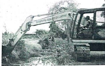
Normalisasi sungai di perbatasan Desa Masangan Kulon dengan Desa Suko, Kecamatan Sukodono.
