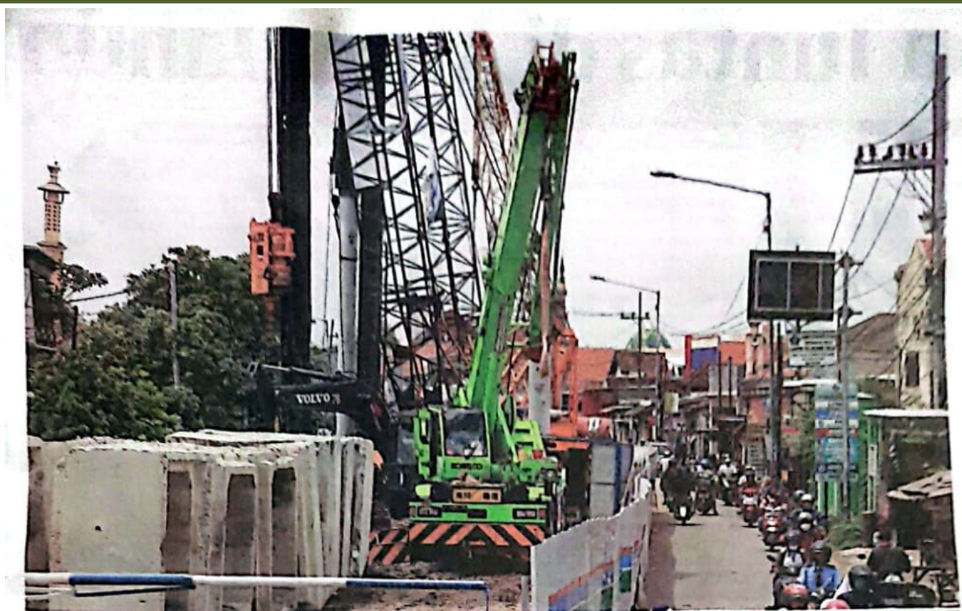
MASIH BISA LEWAT: Selama pembangunan fondasi flyover Krian, Sidoarjo, Jalan Kyai Mojo hanya separo yang ditutup seperti yang terlihat kemarin. Namun, ketika pengerjaan badan jalan, penutupan akan dilakukan secara total.
