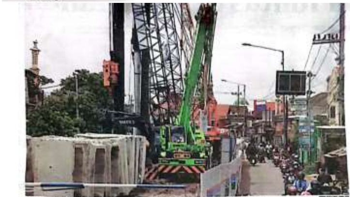
MASIH BISA LENYAP? Selama pembangunan flyover Krian, Sidoarjo, Jalan Kyal Mega harus tetap siap seperti yang terlihat kemarin. Namun, ketika pekerjaan badan jalan, pekerjaan akan dilakukan secara total.
