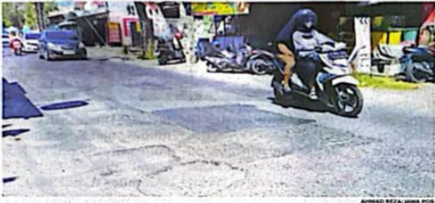
CEGAH KERUSAKAN: Betonisasi di Jalan Bluru Kidul diharapkan memperkuat akses yang rawan rusak saat musim hujan.
