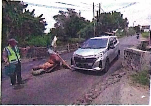
AMBLES LAGI: Warga memasang pemanda di bagian yang rusak di Jembatan Prasung kemarin (11/1).
