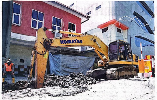
KURANGI TITIK GENANGAN: Pembangunan saluran air difokuskan pada sisi selatan RSUD RT Notopuro Sidoarjo.
