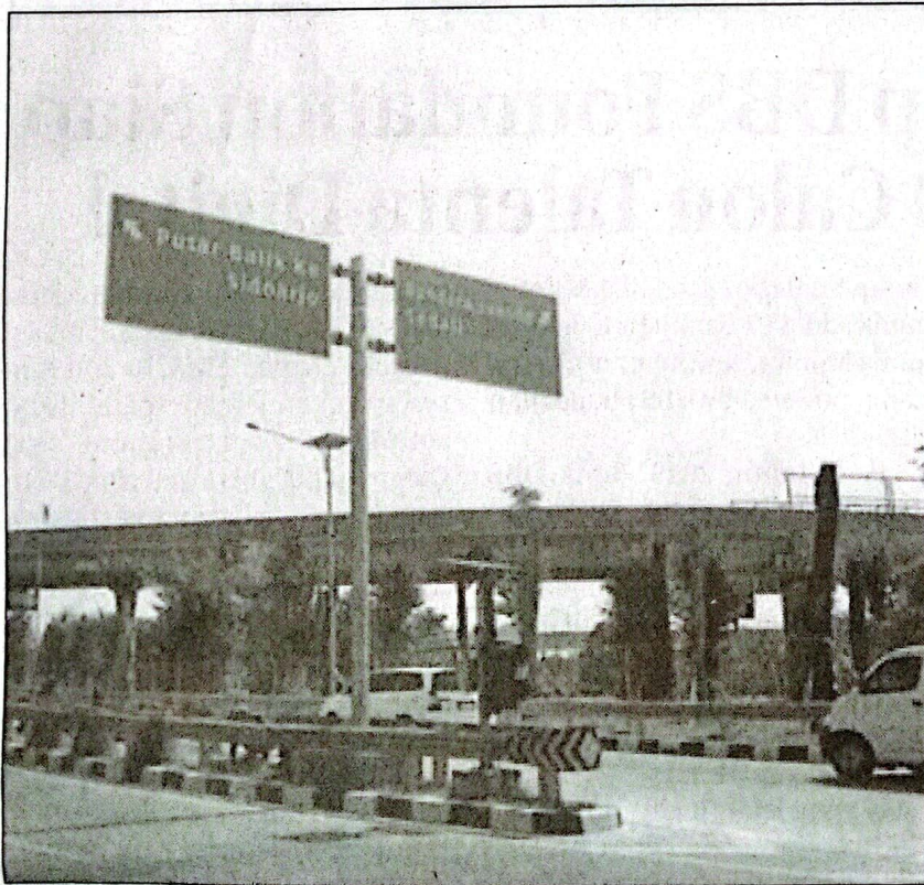
FLYOVER DJUANDA: Direktorat Jenderal Bina Marga telah menyelesaikan pembangunan Flyover Djuanda yang berada di Kabupaten Sidoarjo. BM/ST
