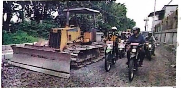
OPTIMISTIS: Bupati Sidoarjo Ahmad Muhdlor (kanan depan) menaiki motor melihat pengerjaan proyek frontage road mulai Waru hingga Buduran.
