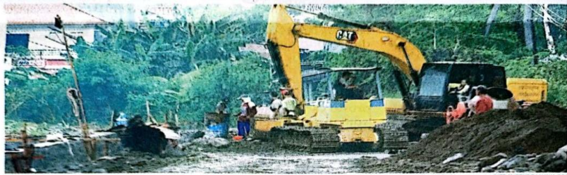
PENGGANTI YANG BOLONG: Pekerja menggunakan alat berat untuk meratakan tanah di frontage road Jenggolo belakang Taman Asa kemarin. Titik tersebut semestinya digarap tahun depan.
