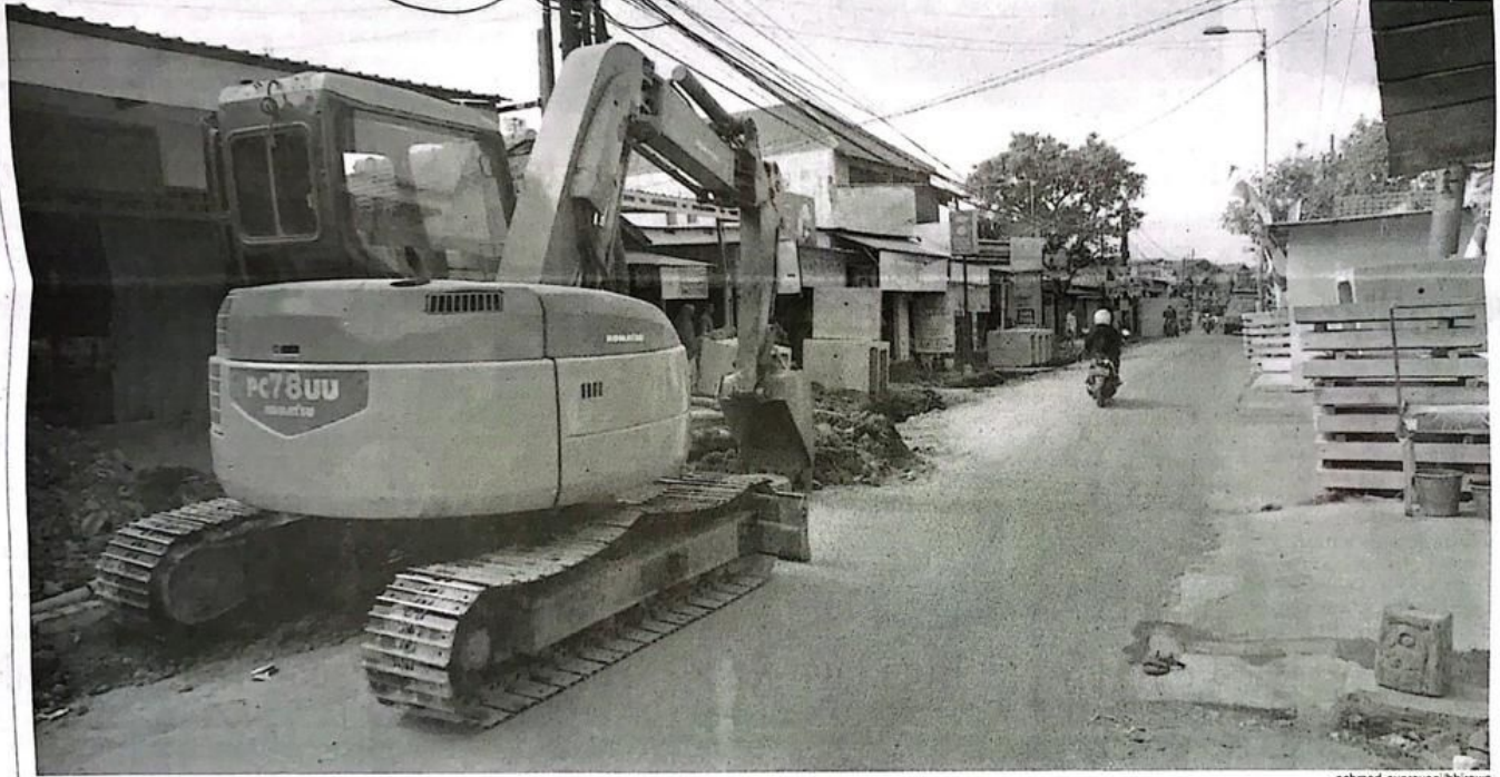
Proses pemasangan U-Ditch di Desa Geluran Taman yang sedang berlangsung.
