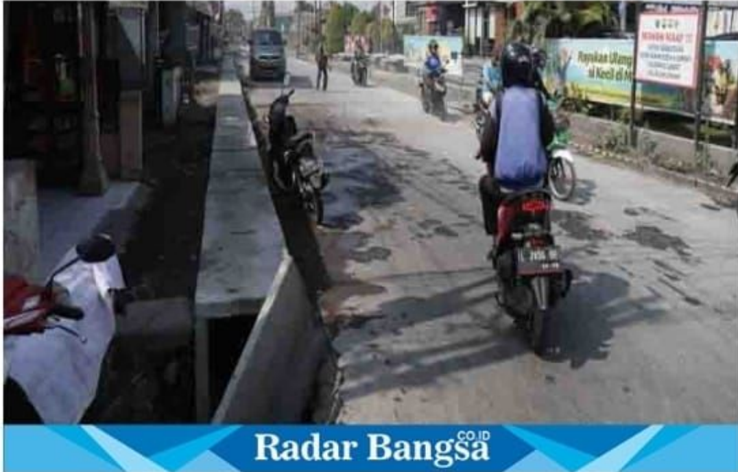
Tampak Betonisasi rampung tinggal drainase, Selasa (8/8) di suko taman (Foto: Radarbangsa)
