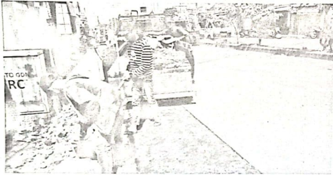
ahmad suprayogi/bhirawa Proses perbaikan jalan rusak akibat galian PDAM di Desa Keboansikep Gedangan.
