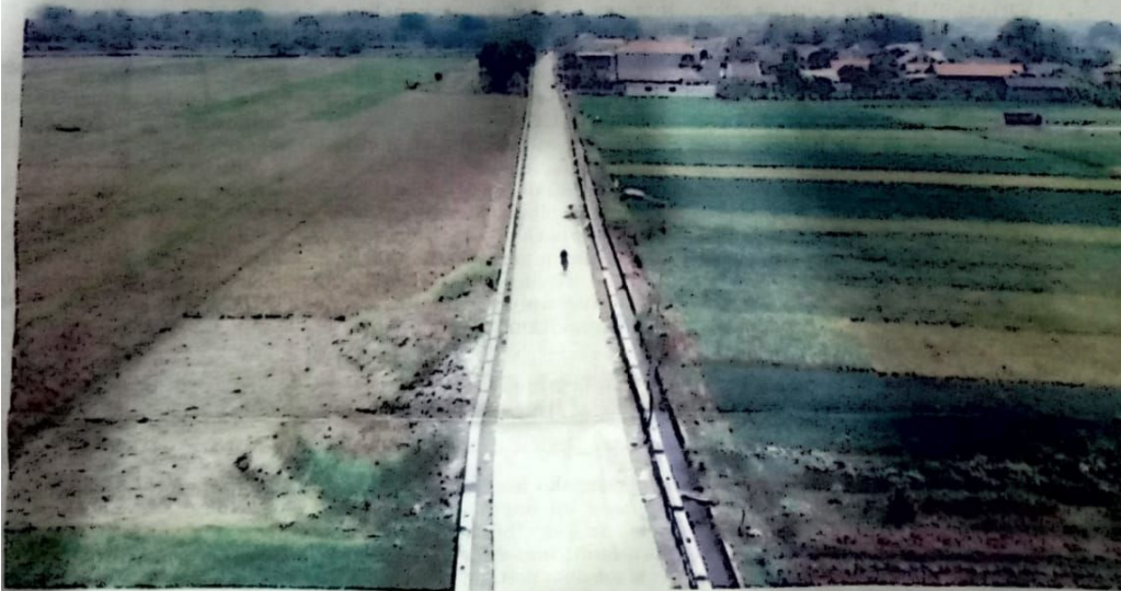
MULUS: Pengerjaan betonisasi di ruas jalan Tarik-Mliriprowo progresnya menjanjikan.
