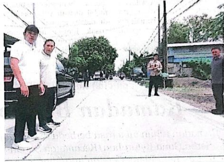
BETONISASI - Sejumlah ruas jalan yang sudah dibeton di Kabupaten Sidoarjo. Jalan-jalan itu yang sekarang bebas dari kerusakan.
