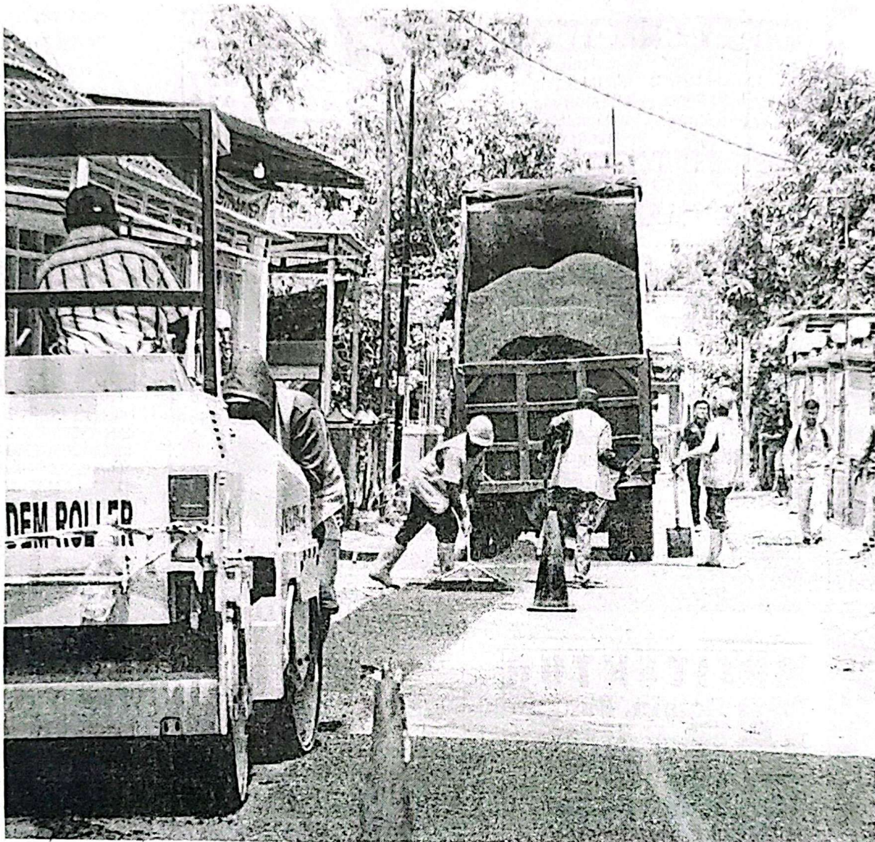
Proses perbaikan jalan rusak di wilayah Sidoarjo, Sabtu (28/2). foto: istimewa
