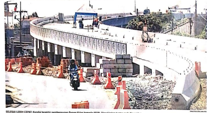
SELESAI LEBIH CEPAT: Kondisi terakhir pembangunan flyover Krian kemarin (10/9). Diperkirakan tuntas pada November.
