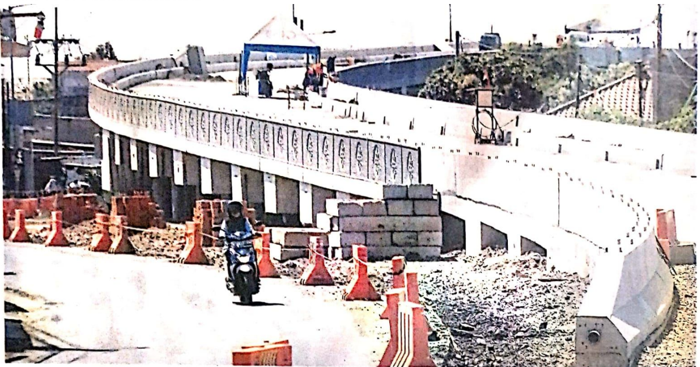
SELESAI LEBIH CEPAT: Kondisi terakhir pembangunan flyover Krian kemarin (10/9). Diperkirakan tuntas pada November.
