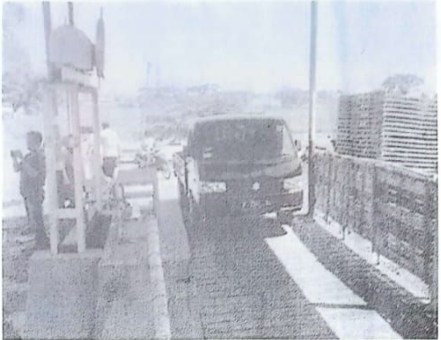
Warga Desa Kedungpeluk, Sidoarjo akhirnya bangun jembatan darurat sendiri.
