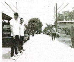
Bupati Sidoarjo Subandi saat sidang di jalan beton Sawotratap Gedangan yang dibekali pokir anggota DPRD, Minggu (8/2).
