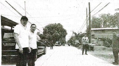
Bupati Sidoarjo Subandi saat sidak di jalan beton Sawotratap Gedangan yang dibiayai pokir anggota DPRD, Minggu (8/2).
