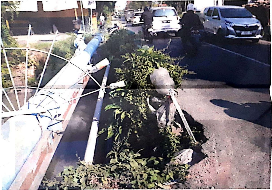
RUSAK LAMA: Kondisi aspal di jembatan Jalan Kemuning, Sumpat, Sidoarjo, yang memakan korban pengendara roda dua kemarin.
