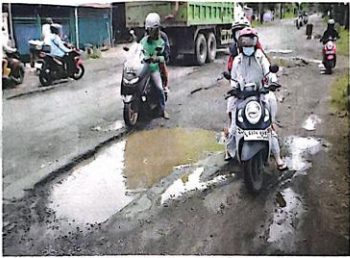
RUSAK PARAH: Perbaikan jalan di seluruh wilayah, termasuk di Lingkar Timur, ditargetkan rampung sebelum Lebaran.
