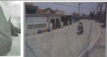
Proses betonisasi jalan di salah satu desa.
