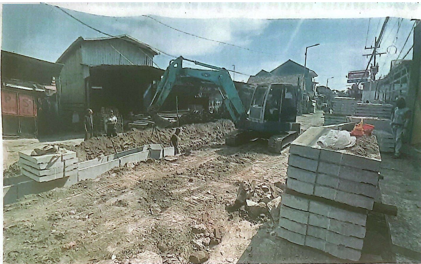
DIKERJAKAN: Pemasangan U-Ditch di Jalan Kureksari Kecamatan Waru sebagai awal dari proses pelaksanaan betonisasi.
