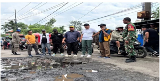
Bupati Subandi saat sidak jalan rusak (Foto : Diskominfo)
