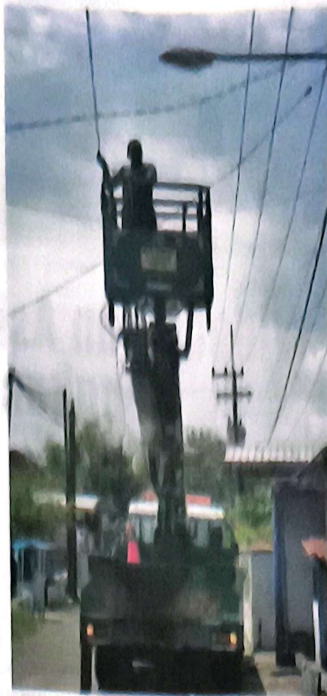
MENYALA: PJU di Krembung, Sidoarjo, saat dilakukan perbaikan.
