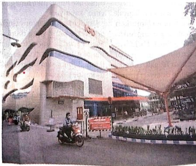
BERBENAH: Gedung Instalasi Gawat Darurat (IGD) RSUD Sidoarjo, Jalan Majapahit. Kemarin dana perbaikan RSUD sudah digedok.
