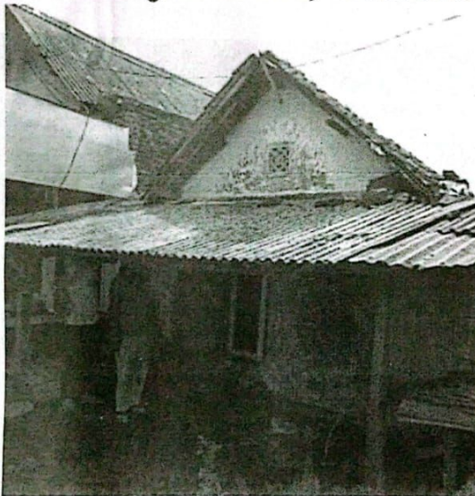
Salah satu rumah warga yang di rehabilitasi.
