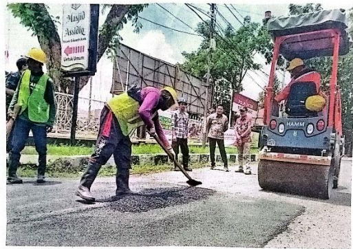
MASIF: Proses perbaikan jalan rusak terus dilakukan Pemkab Sidoarjo jelang Lebaran.
