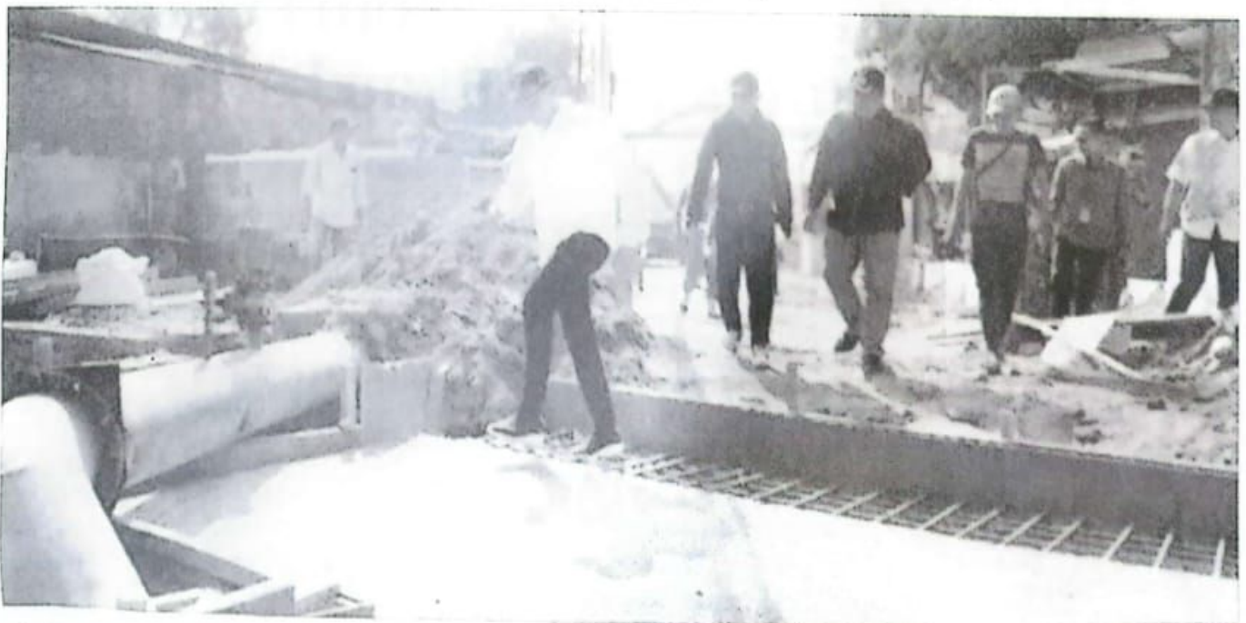
SIDAK: Plt Bupati Sidoarjo Subandi saat melihat langsung proses pembangunan jalan dan jembatan di Desa Banjarsari, Kecamatan Buduran, Sidoarjo.
