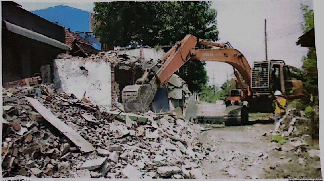
ALAT BERAT: Petugas membongkar bangunan di Desa Gedangan untuk pengerjaan frontage road.
