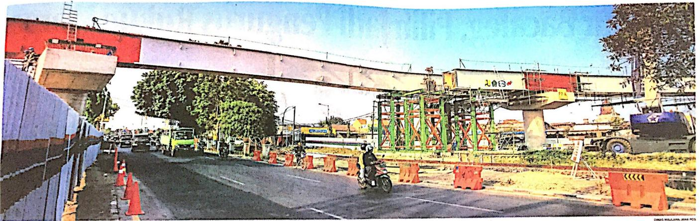
ERSAMBUNG: Girder flyover Djuanda di sisi utara tuntas terpasang (3/10). Saat ini dua balok girder sudah terpasang. Pengerjaan pemasangan girder harus tuntas hari ini.
