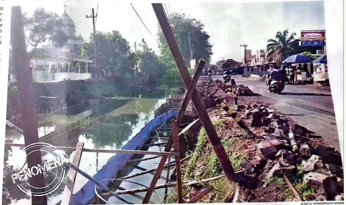
DIPERKUAT: Pengerjaan perbaikan plengsengan sungai di depan Pasar Sidokerto, Kecamatan Buduran.
