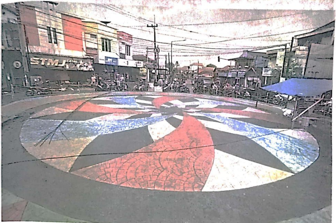
WARNA-WARNI: Bagian tengah pertigaan Tulangan yang sedang dikerjakan. Proyek betonisasi kawasan tersebut berjalan lebih cepat dari prediksi.
