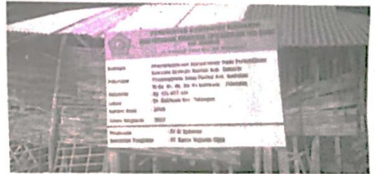
Proyek pembangunan pemeliharaan pavingisasi di RT4,5,6 RW 4 desa Kajeksan dusun Godekan yang diduga tidak transparan pada publik di papan namanya tidak tertera tertera besarnya volume pekerjaan.
