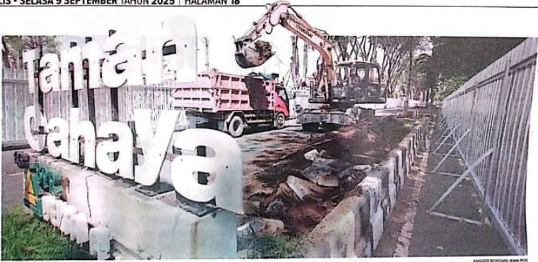
LALU LINTAS DIALIHKAN: DLHK Sidoarjo menutup Jalan Cokronegoro dan membongkar taman median jalan kemarin (8/9).
