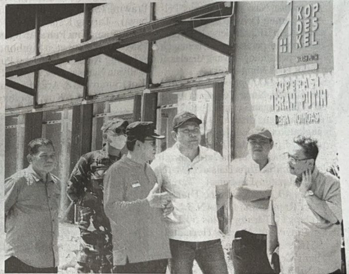
Bupati Subandi meninjau pembangunan Kopdes merah putih Desa Ngingas Kecamatan Waru. aikus/bhirawa
