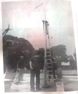
FASILITAS LENGKAP: Pemasangan unit wifi dan CCTV di Alun-Alun Sidoarjo.
