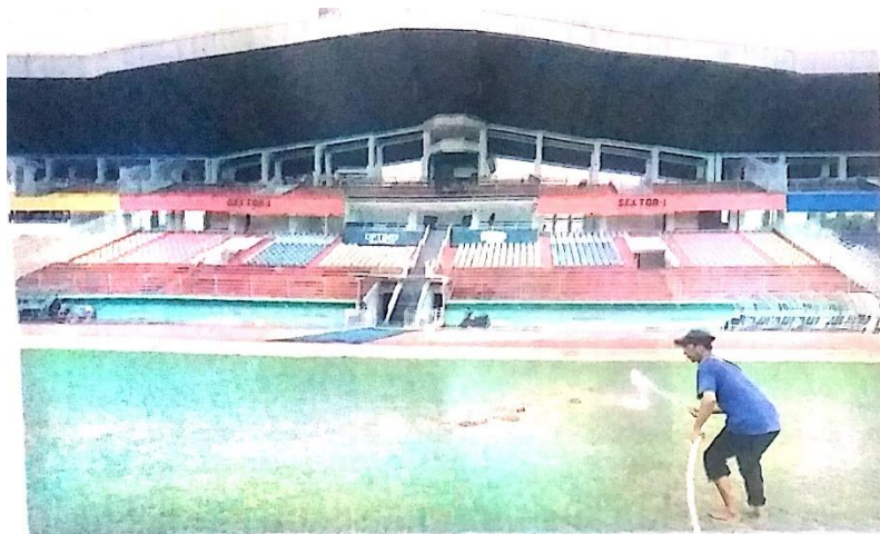
DIGANTI TOTAL: Pekerja membersihkan rumput di Stadion Gelora Delta Sidoarjo kemarin. GOR digarap mulai 28 Januari hingga Agustus mendatang.
