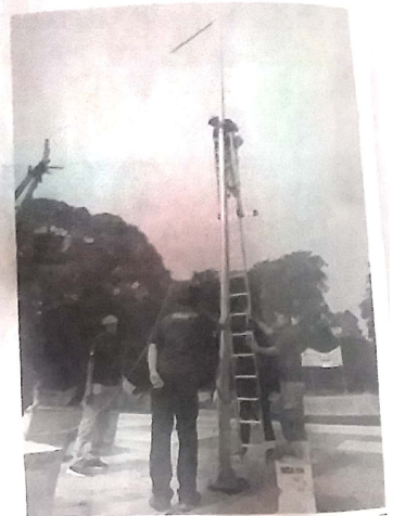
FASILITAS LENGKAP: Pemasangan unit wifi dan CCTV di Alun-Alun Sidoarjo.
