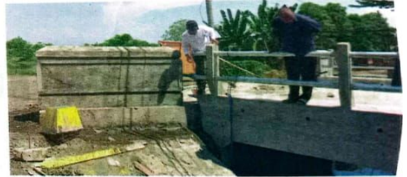
MEMANTAU: Asisten Administrasi Perencanaan dan Pembangunan Sekretariat Daerah (Setda) Kabupaten Sidoarjo, Muhammad Mahmud (kiri) saat mengecek pembangunan Jembatan Kedungpeluk.
