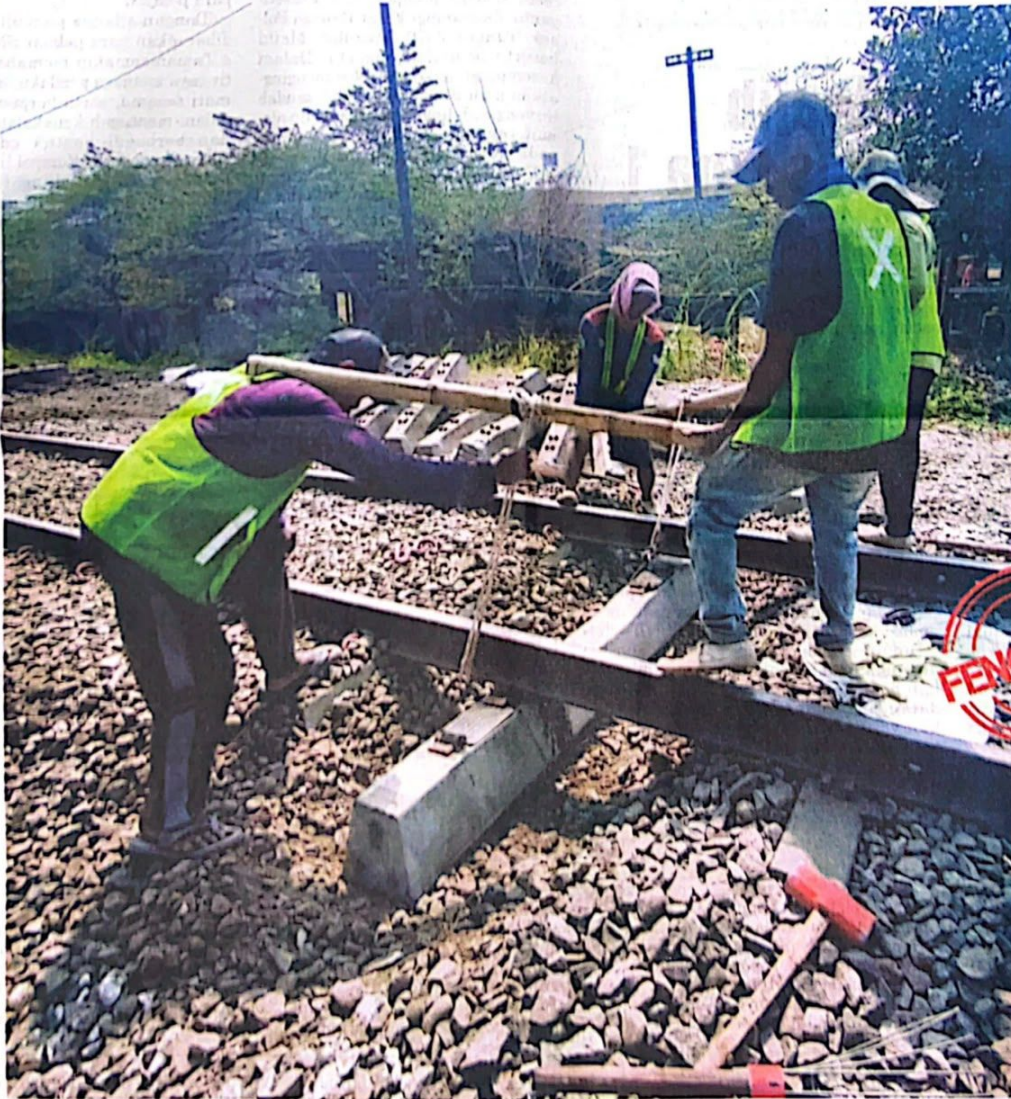
KERJA KERAS: Pekerja menyelesaikan penggantian bantalan beton di jalur kereta api di Porong, Sidoarjo.
