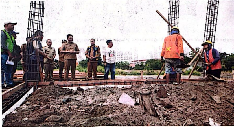
ATASI BANJIR: Bupati Sidoarjo Subandi saat meninjau pembangunan rumah pompa dan embung Sekardangan, Senin (26/10).
