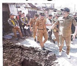
SIDAK: Bupati Subandi (kanan) meninjau betonisasi Jalan Bluru Kidul kemarin (13/7). Pemkab menargetkan pembangunan jalan sepanjang 1,6 kilometer itu rampung Desember 2026.
