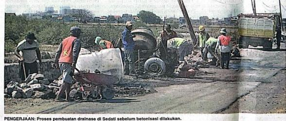
PENGERJAAN: Proses pembuatan drainase di Sedati sebelum betonisasi dilakukan.
