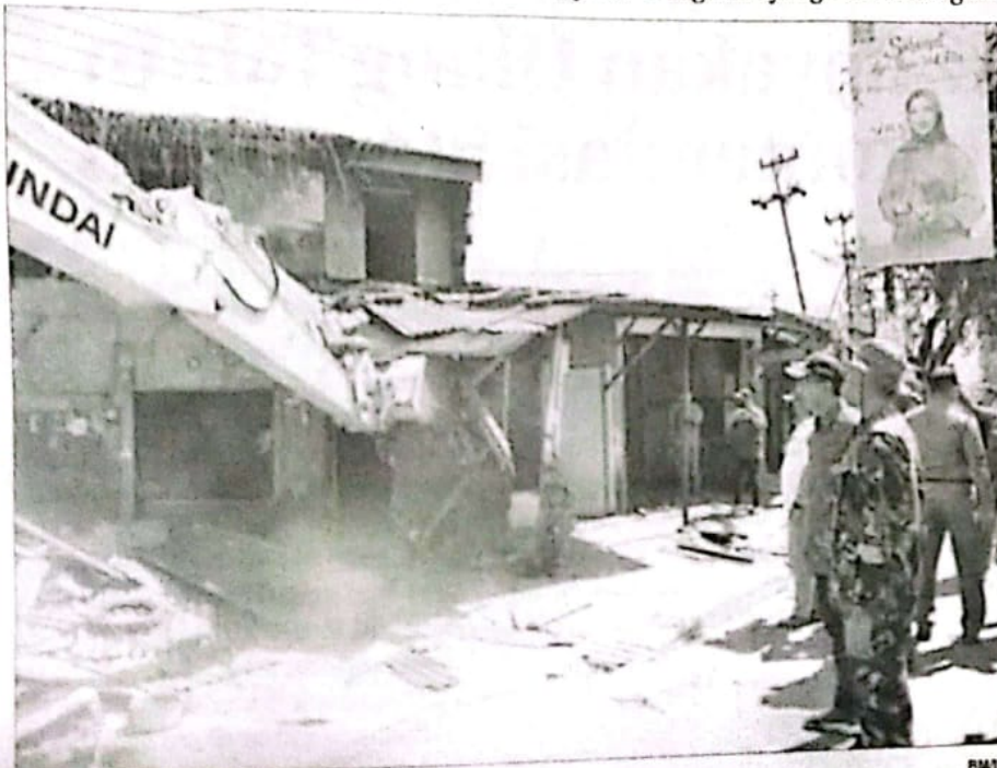
DIBONGKAR: Puluhan bangunan yang terkena imbas proyek pelebaran jalan pertigaan Bangah - Aloha, Kecamatan Gedangan mulai dilakukan pembongkaran, Kamis (21/7). Pembongkaran dilakukan dengan menggunakan alat berat.
