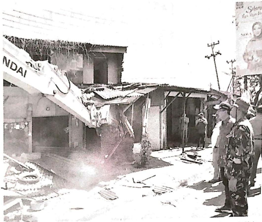
Bupati Muhdlor memimpin pembongkaran bangunan terimbas pelebaran pertigaan Bangah-Aloha, Kamis (21/7).
