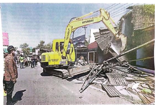
DOKUMEN AGUSTUS: Wakil Bupati Ahmad Muhdlor Ali memimpin pembongkaran bangunan terdampak pelebaran jalan bagian Aloh, Gedangan, kemarin.
