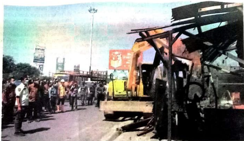
LANCAR: Proses pembongkaran bangunan di kawasan Simpang Tiga Bangah, Aloha menggunakan alat berat.
