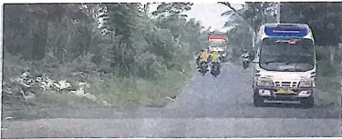
MULAI DILELANG: Kendaraan melintas di Jalan Raya Tlocor, Jabon, kemarin. Tahun ini jalan tersebut dilebarkan menjadi 9 meter. pengawasan proyek pelebaran jalan Jabon sudah berlangsung. Kabid Jalan dan Jembatan DPUBMSDA Sidoarjo Rizal
