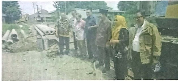
CEK: Komisi C DPRD Sidoarjo melihat progres pembangunan Frontage Road Gedangan Segmen 2.0
