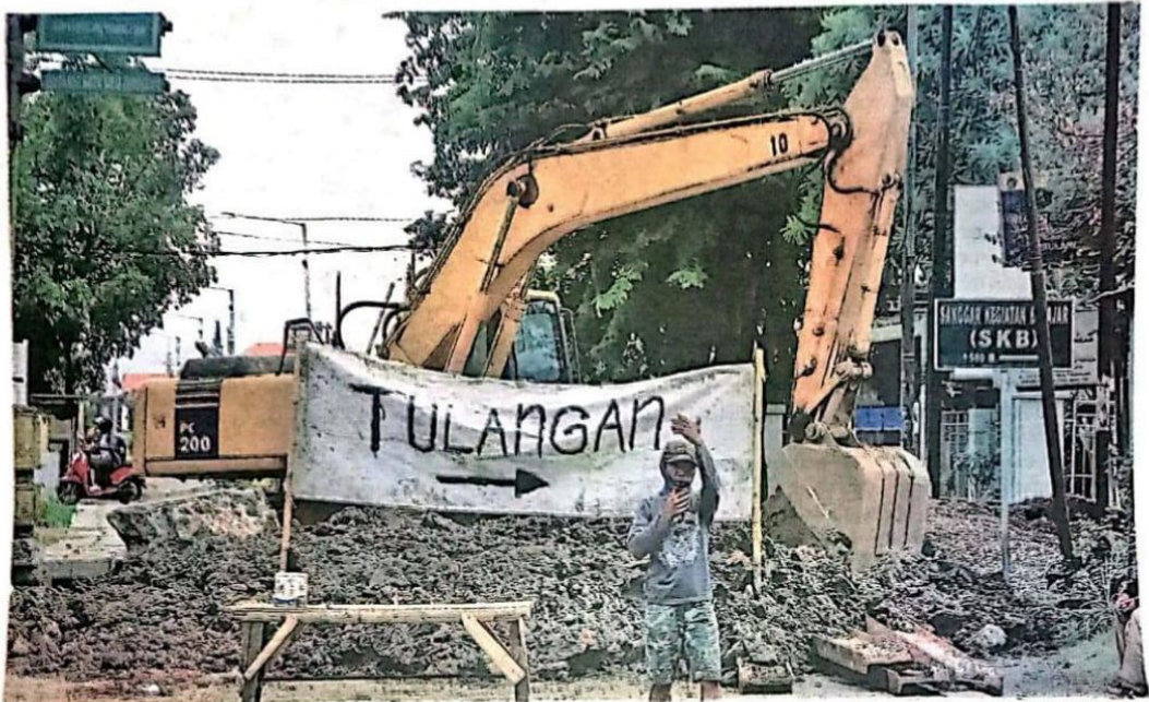
INISIATIF: Warga membantu mengatur lalu lintas di sekitar proyek pembangunan drainase di Jalan Raya Kemantren, Kecamatan Tulangan, kemarin.
