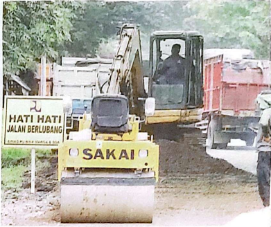
PENGASPALAN: Perbaikan Jalan Lingkar Timur yang rusak parah masih berlangsung hingga kemarin (10/3). Jalur itu diusulkan menjadi jalan nasional.
