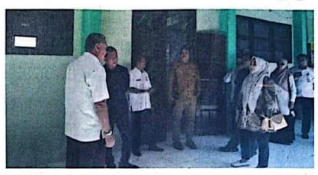
MENINJAU: Komisi C DPRD Sidoarjo melakukan sidak ke SMPN 2 Wonorejo yang bangunannya rusak akibat angin kencang, Rabu (6/11). Foto: Harian Bangsa
