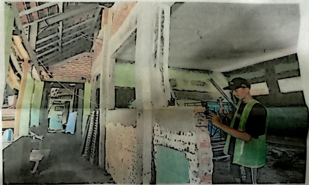
RUSAK BERAT: Pekerja memperbaiki salah satu kelas SDN Waru 2 yang rusak kemarin (4/10). Pengerjaan diperkirakan tuntas Desember.
