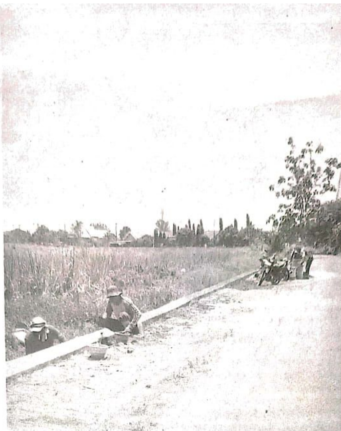
KEBUT KERJA : Pekerja bangunan kebut pekerjaan pendamping jalan yang menghubungkan Dusun Awar-Awar Gunting dan Dusun Tambakrejo, Krembung. (gus)
