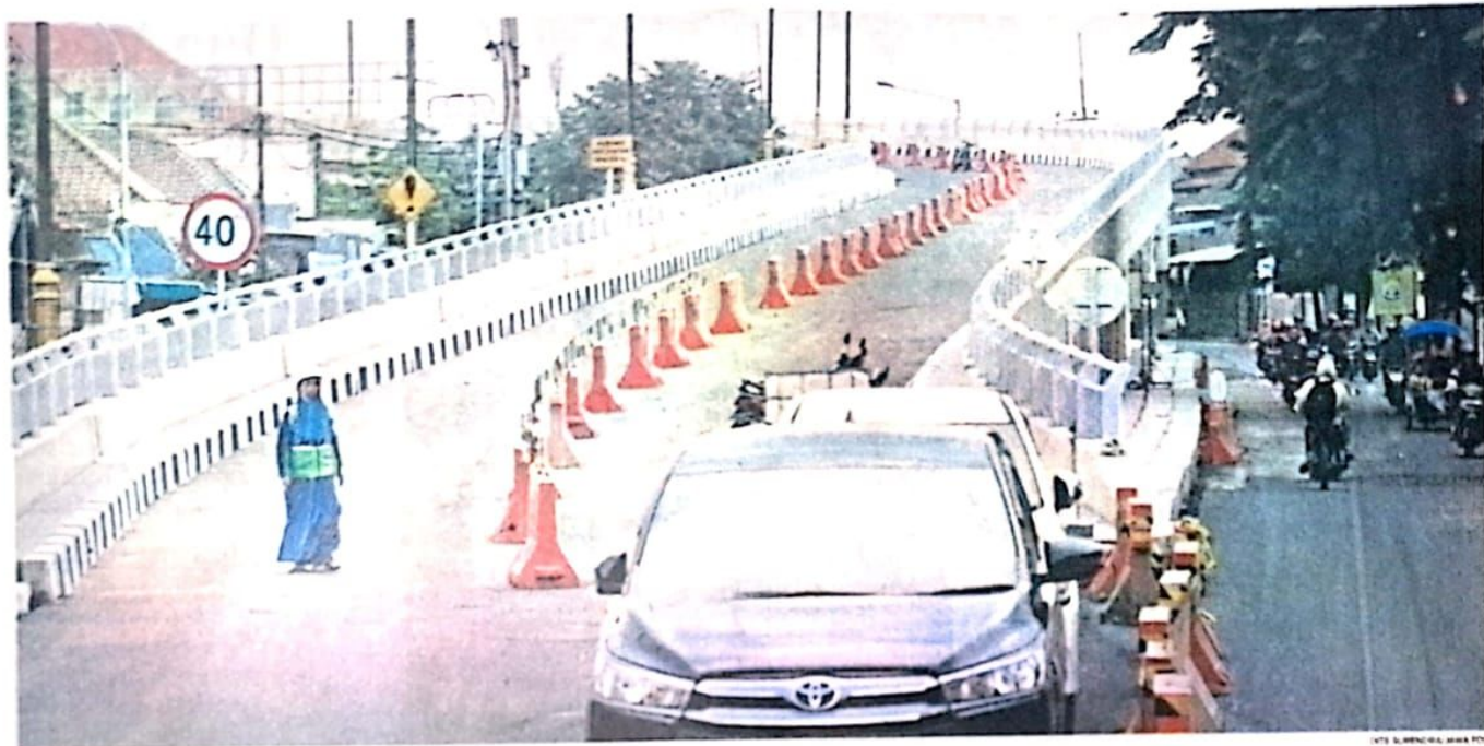
UJI COBA: Petugas memasang traffic cone di flyover Krian yang tuntas terbangun kemarin (11/12). Mulai hari ini, pemotor sudah bisa melewati flyover.
