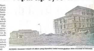
Progres pembangunan di salah satu lokasi investasi di Kabupaten Sidoarjo.
